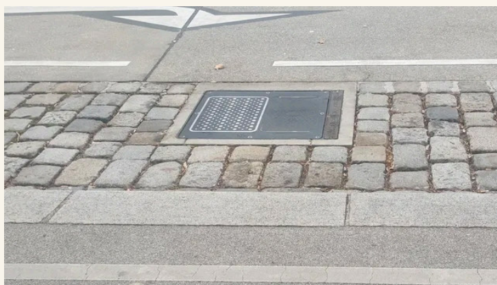
Eine Ladeplatte des Pilotprojekts eTaxi Austria. (© Falter/Klimpfinger)
