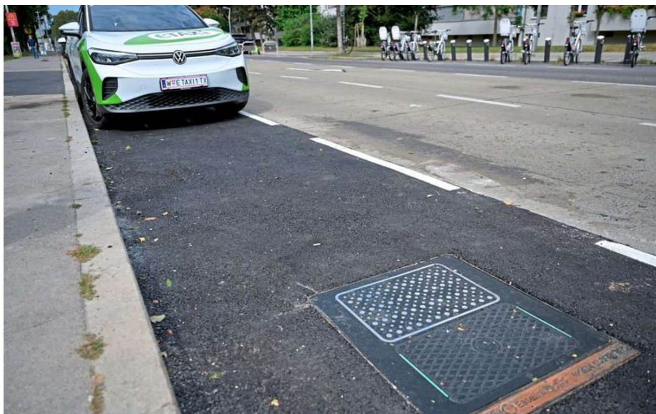
Unter Koordination der WK Wien werden automatische Ladeflächen des Start-ups Easelink in Wien und Graz ausgetestet. Über Pilotprojekte hinaus gibt es wenig Zählbares.
